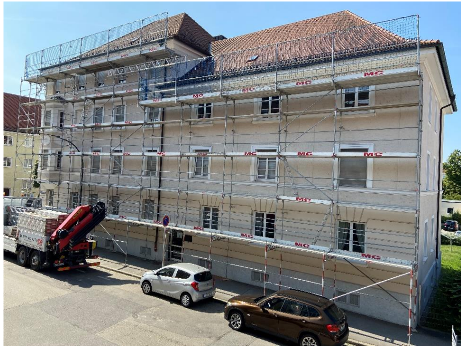
Vorbereitung für die Installation der PV-Anlage in der Franz-Seiff-Straße 1
