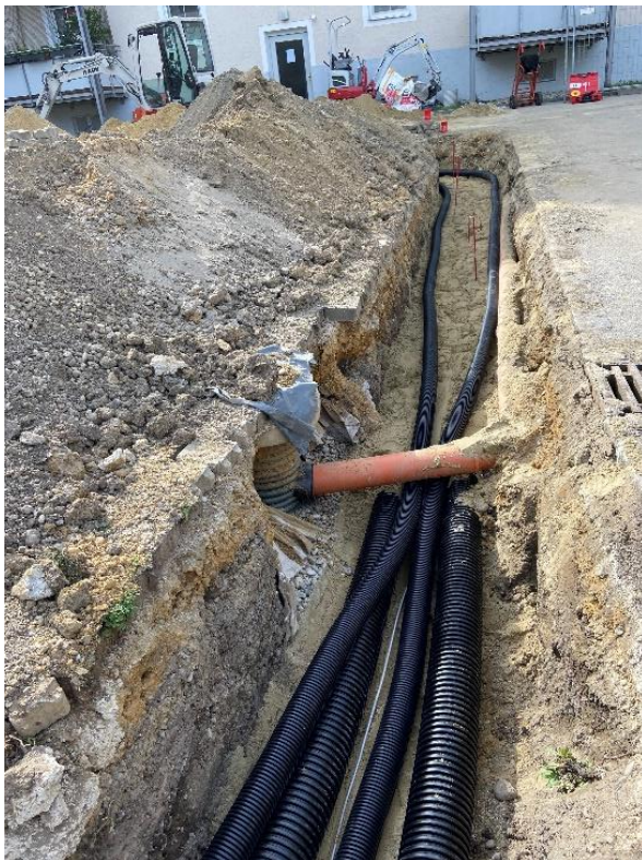
Anschlussleitungen für Wärmepumpe in der Stethaimerstraße 19; Franz-Seiff-Straße 1
