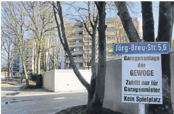
In den nächsten vier Jahren wird die Jörg-Breu-Straße eine große Baustelle, doch danach sind die Gebäude „nagelneu“.
